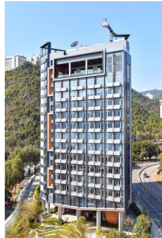
创新斗室 (香港首幢「组装合成」高楼层建筑项目)
